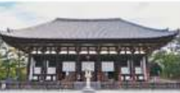
東金堂 奈良時代に聖武天皇が建てましたが、度々の火災にあい、今の塔は1415年6度目に再建されたものです。
