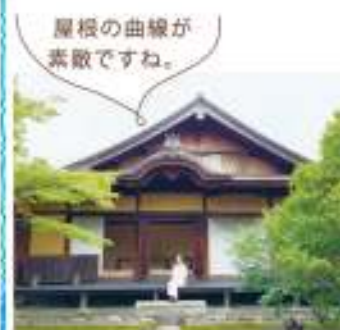
檜皮葺(ひわだぶき) 瓦が伝わる以前からある檜皮葺きです。
