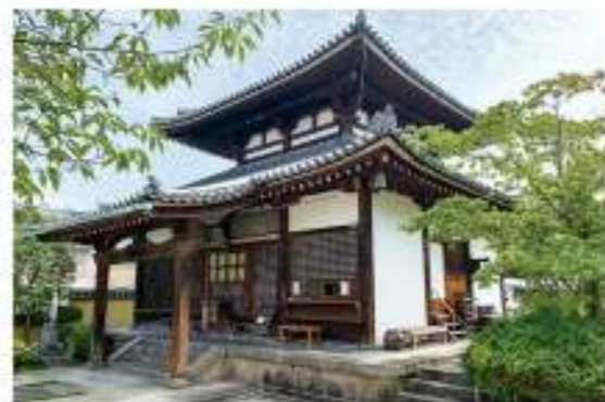
福智院本堂(国、重要文化財) 254年建立、屋根は奇峰造り、本瓦葺です。四方に四間のもこしが回っています。
